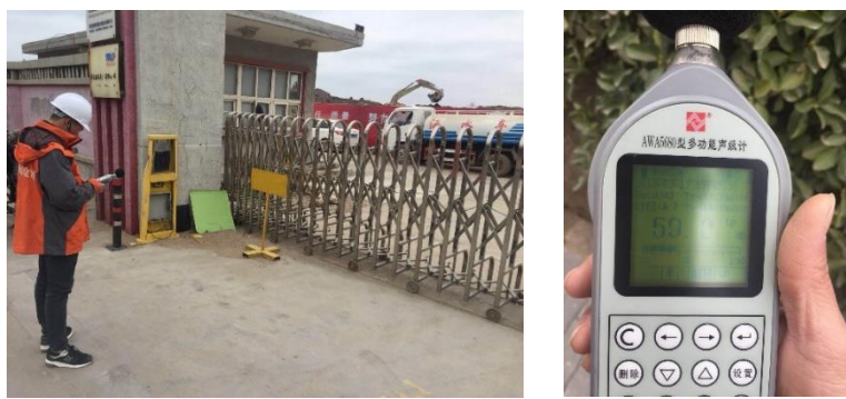
图 6-13 施工现场噪声检测
