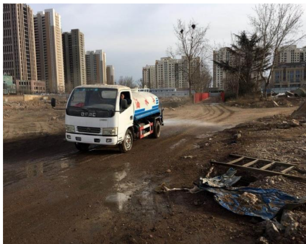
图 6-9 现场洒水设备
