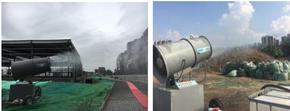
图 6-11 现场喷雾降尘设备
