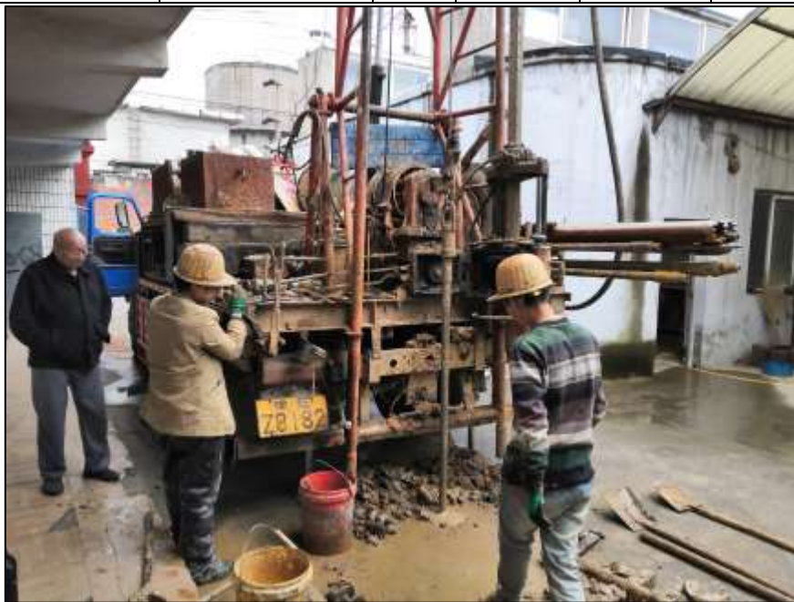
图 3-5 现场建井钻孔
