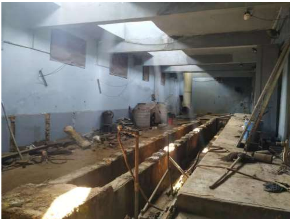
图 2-8 电镀操作线拆除后的电镀操作间现状
